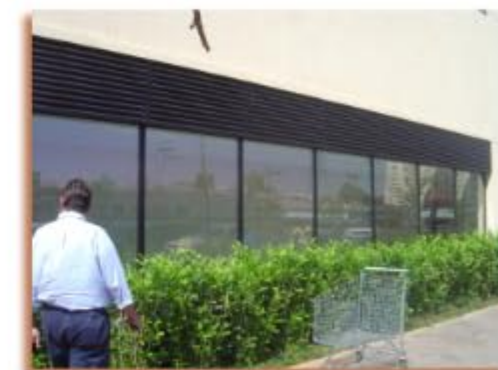
VISTA EXTERNA: VENEZIANA PROTEGIDA PELA VEGETAÇÃO E SOBRE O VIDRO INSULADO COM CÂMARA DE 9mm
