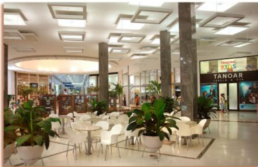
LUMINÁRIAS COM LÂMPADAS FLUORESCENTES PROJETADAS PARA PERMITIR A EXAUSTÃO DO AR DO MALL
