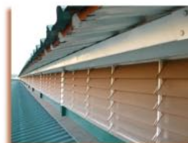
TELHA SANDUÍCHE QUE PROMOVE ISOLAMENTO TÉRMICO SOBRE O MALL
